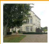
4 Château de l'Ermitage Rue de l'Ermitage, 23
